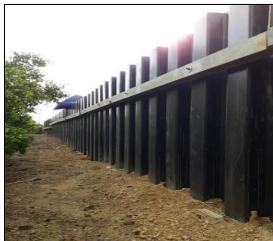
Figura 20. Obra en funcionamiento
