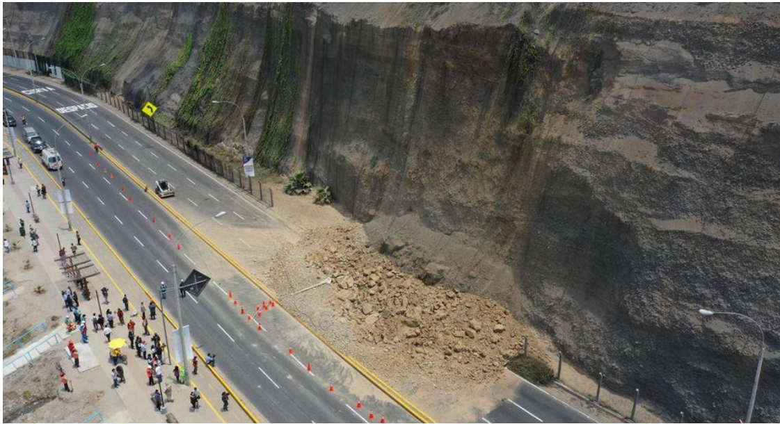
Figura 12. Imagen de los deslizamientos en la costa verde Año 2019
