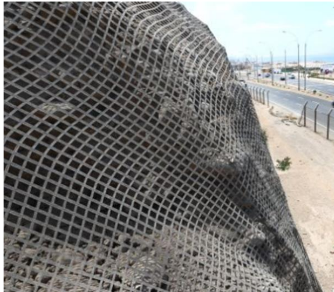
Figura 7. Foto de las Geomallas instaladas.
