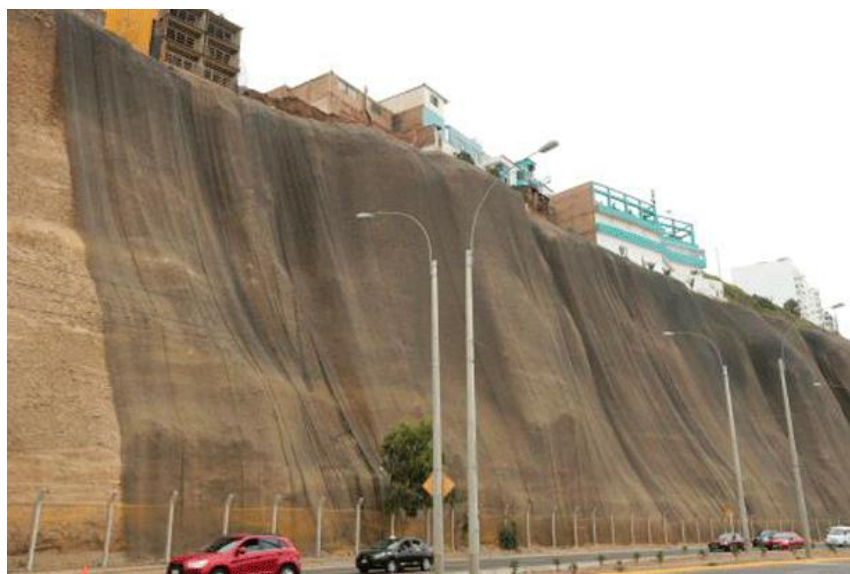
Figura 11. Imágenes de las Geomallas instaladas.
