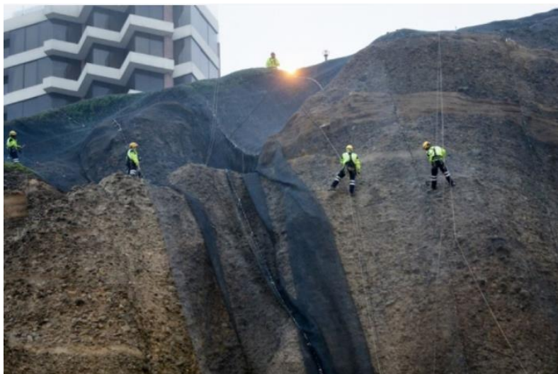
Figura 9. Instalación de Geomallas
