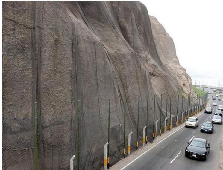
Figura 10. Imágenes de las Geomallas instaladas.
