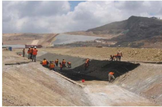
Figura 1. Canal tradicional con Geocelda y Concreto.
