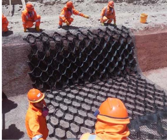
Figura 3. Canal con tensores multiaxiales, sin estacas.
