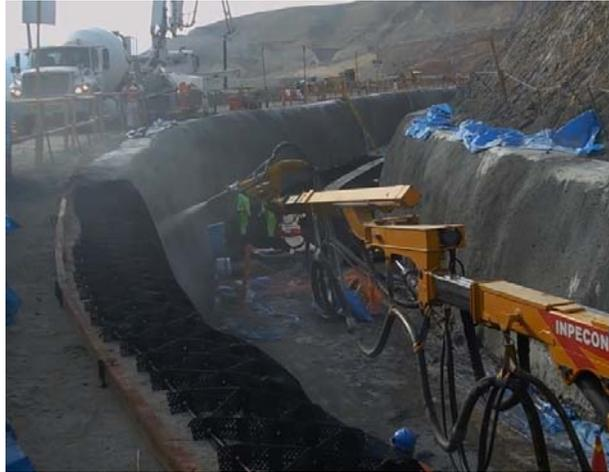
Figura 8. Canal minero de 70 m<sup>3</sup>/seg revestido con Geoceldas y Shotcrete
