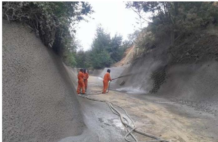
Figura 7. Canal agrícola de 15 m<sup>3</sup>/seg revestido con Geoceldas y Shocrete
