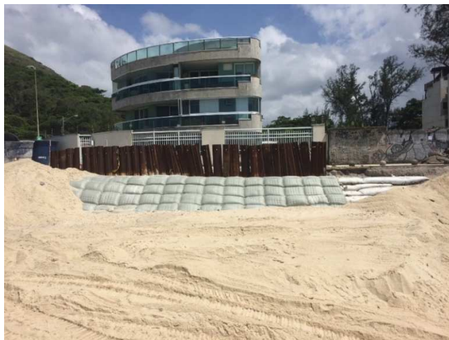
Figure 13 - Protection of foundation - Praia da Macumba - Rio de Janeiro / RJ
