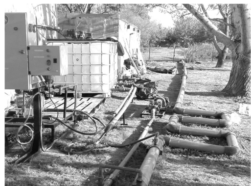
b) Unidad de coagulación, floculación y serpentín de mezcla
