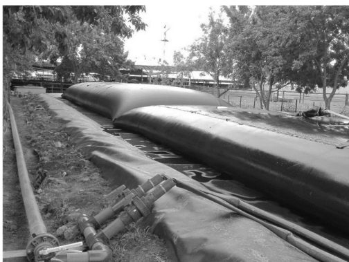
a) Geocontenedores y celda de contención de líquido filtrado
