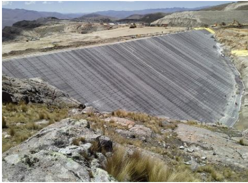
a) Site overview
