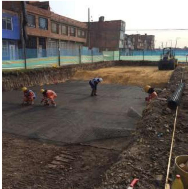
Figura 10. Instalación del Geotextil tejido y de la Geomalla Biaxial Coextruida.
