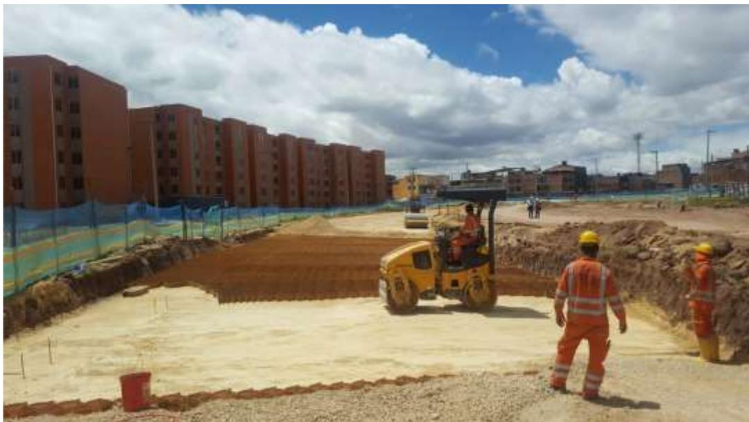
Figura 12. Instalación de la Geocelda de Confinamiento Celular
