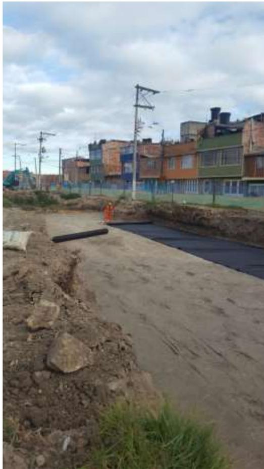
Figura 11. Instalación y extensión del Geotextil
