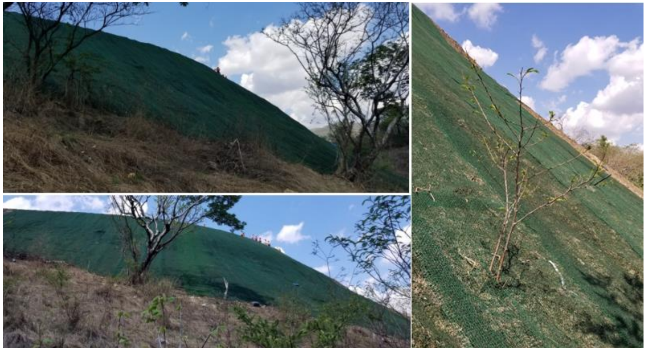
Figura 15. Culminación de instalación de geomanta tridimensional en taludes de planta de beneficio (Capela).
